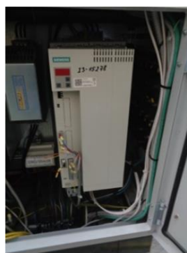
Obr. 25 Příklady provedení frekvenčních měničů pro průmyslové pohony s asynchronními motory, pohled na řídicí obvody frekvenčního měniče – jsou patrné i elektrolytické kondenzátory stejnosměrného meziobvodu
